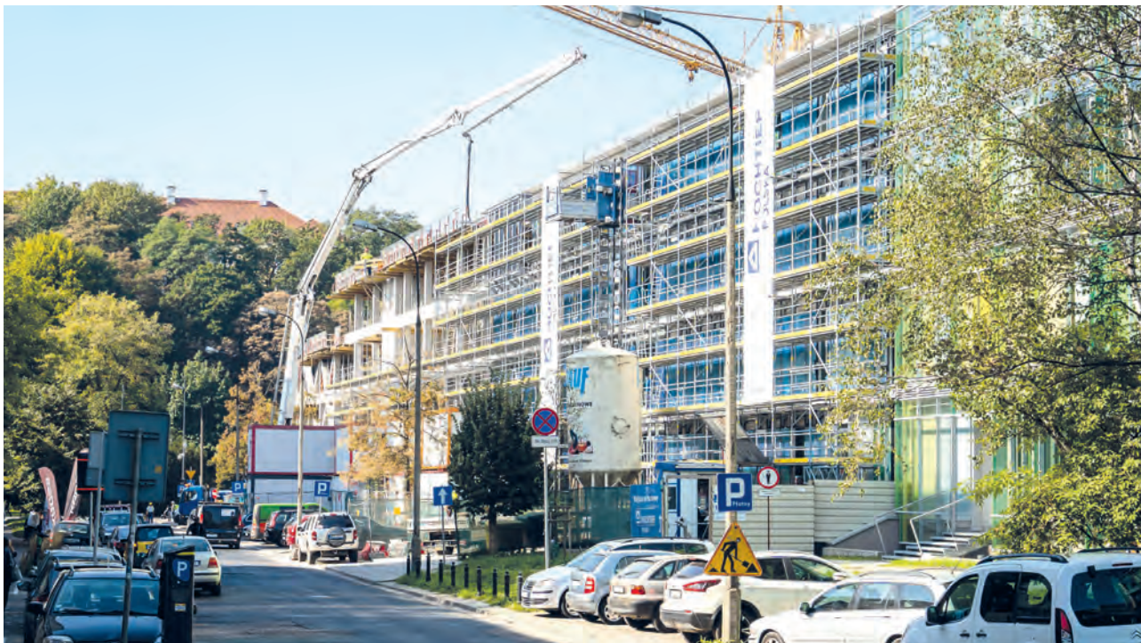
Budowa budynku przy ul. Dobrej 55. Widok od strony ul. Lipowej, wrzesień 2020 roku.
